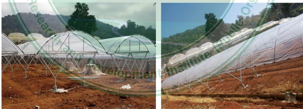
ภาพที่ 6 โรงเรือนและค้ำตัววายต่ำ 1.5 เมตรแบบหลังคาปิดขนาด 3 x 20 เมตร
