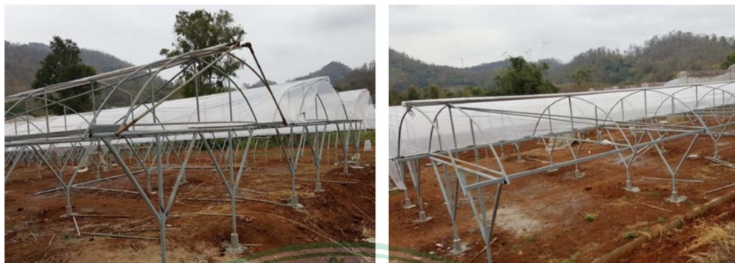
ภาพที่ 7 โรงเรือนและค้ำตั้งว้ายดำ 1.5 เมตร แบบหลังคาปิด-เปิด ขนาด 3 x 20 เมตร
