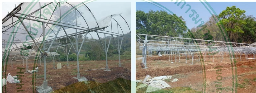
ภาพที่ 5 โรงเรือนและค้ำตัววายสูง 2 เมตร แบบหลังคาปิด-เปิด ขนาด 3 x 20 เมตร
