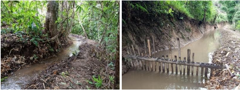
ภาพที่ 48 ที่บ่อโกล เหมืองดินขนาดเล็กที่ขุดไล่เลาะขอบเขาเพื่อลำเลียงน้ำสู่นาขั้นบันได
