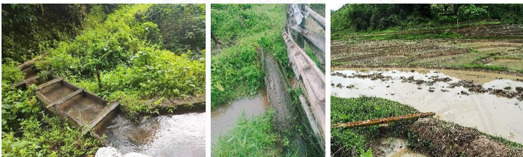
ภาพที่ 49 ลิ ท่อลำเลียงน้ำทำจากท่อนไม้ที่ขุดเจาะด้านในให้เป็นร่องหรือไม้ไผ่ผ่าซีก เพื่อใช้ในการส่งน้ำข้ามสิ่งกีดขวาง
