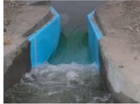
รูปที่ 1 แสดงรูปแบบของ Cut-throat Flume
