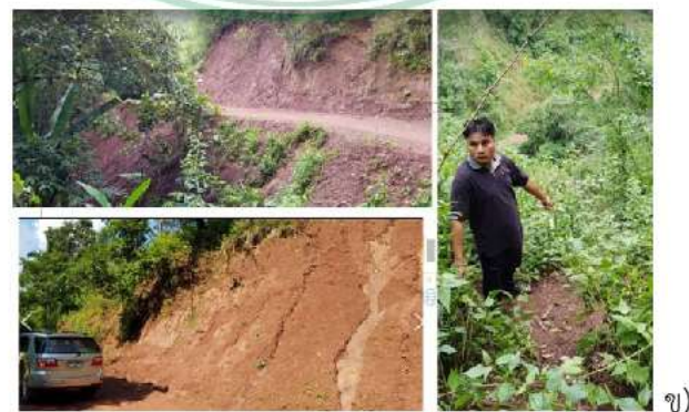
ภาพที่ 4.69 ปัญหาการกัดเซาะเป็นร่องลึกในเขตชุมชน และการชะล้างพังทลายบริเวณถนน ในพื้นที่บ้านน้ำจูน โครงการพัฒนาพื้นที่สูงแบบโครงการหลวงบ่อเกลือ จังหวัดน่าน
