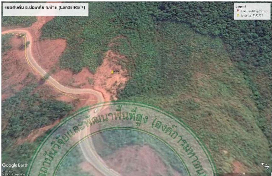
ภาพที่ 4.222 ร่องรอยการเคลื่อนตัวของดินและดินถล่มเหนือริมทาง โครงการพัฒนาพื้นที่สูงแบบโครงการหลวงบ่อเกลือ ตำบลดงพญา อำเภอบ่อเกลือ จังหวัดน่าน
