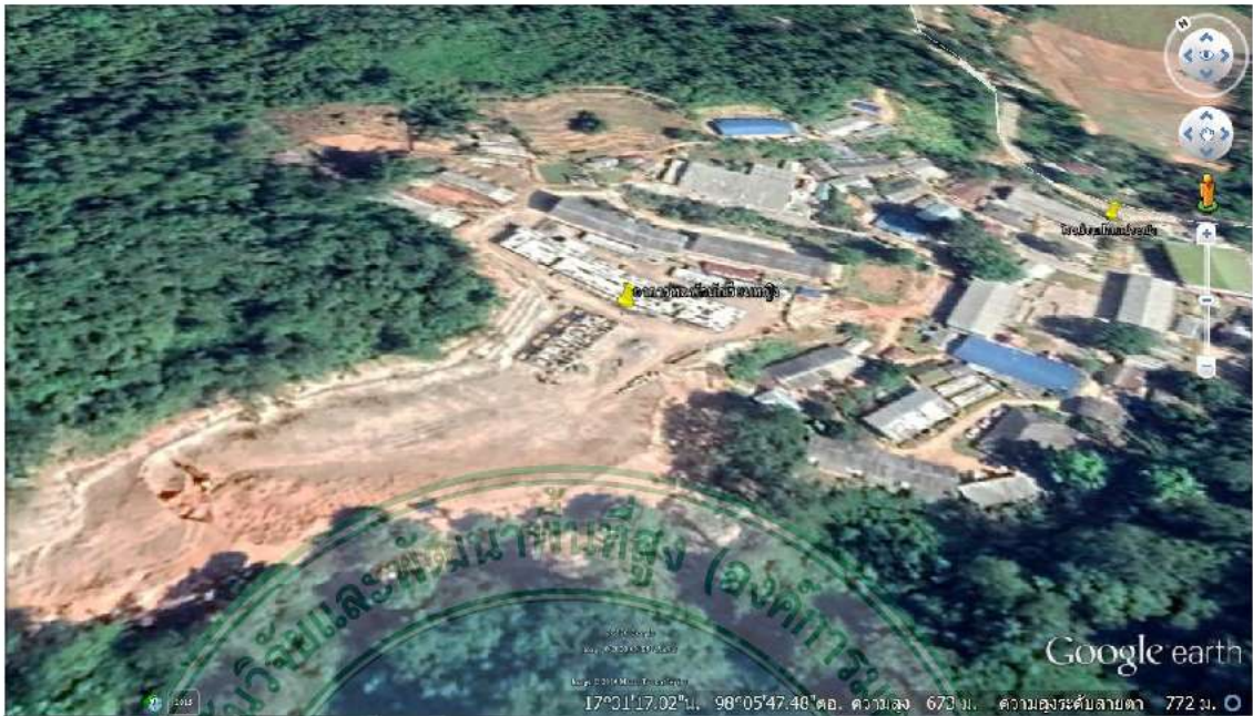
ภาพที่ 4.1 ดินสไลด์ที่อาคารหอพักนักเรียนหญิง ที่โรงเรียนบ้านแม่ระเมิง
