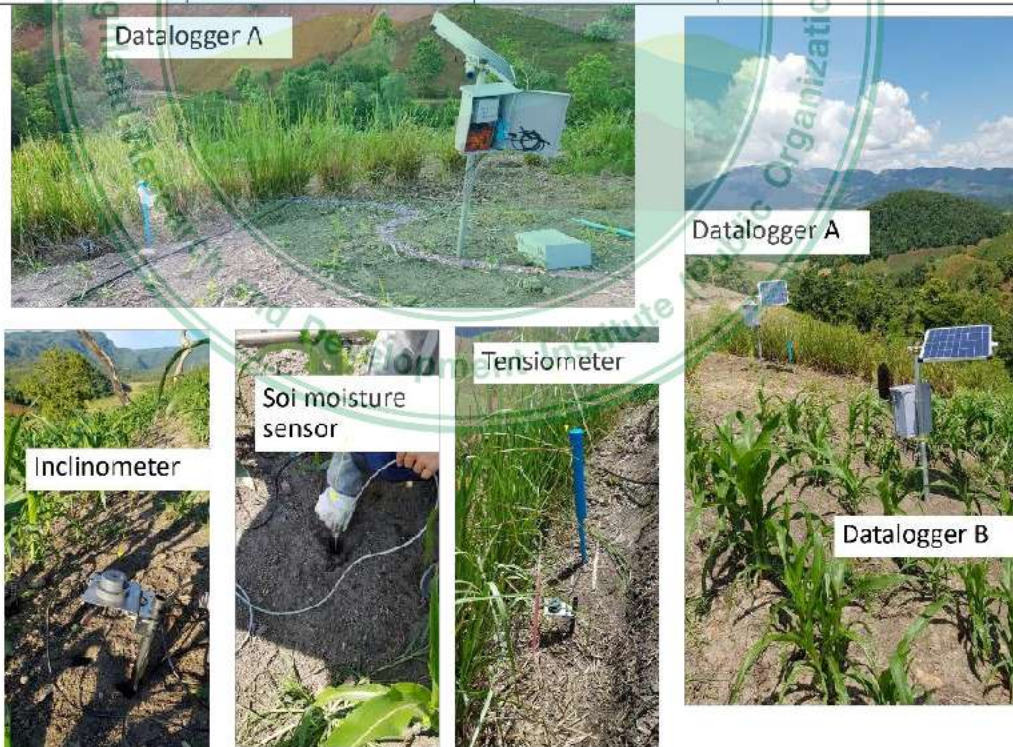
ภาพที่ 4.34 อุปกรณ์ตรวจวัดดินถล่มซึ่งติดตั้งใน แปลงข้าวโพด บ้านแม่วาก โครงการพัฒนาพื้นที่สูงแบบโครงการหลวงแม่ละออ จังหวัดเชียงใหม่
