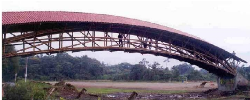
ภาพที่ 36 ตัวอย่างการสร้างสะพานที่ใช้ไม้เป็นวัสดุดิบ จึงควรเลือกไม้ที่มีความแข็งแรงในการรับแรงคัตได้ดี
