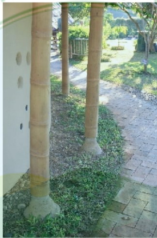
ภาพที่ 37 ตัวอย่างการใช้ลำไผ่มาใช้งานเป็นเสาของอาคารบ้านเรือน ควรเลือกไม้ที่มีความสามารถรับแรงคัตได้ดี รวมถึงมีขนาดเส้นผ่าศูนย์กลางลำขนาดใหญ่ด้วย
