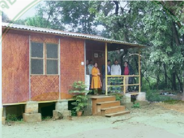
ภาพที่ 34 การนำแผ่นไม้ไผ่เพื่อใช้งานเป็นผนังอาคาร
