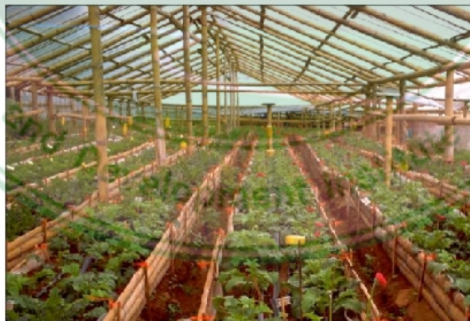
ภาพที่ 24 ตัวอย่างการใช้ลำไฝเป็นวัสดุก่อสร้าง ส่วนของโครงสร้างที่ถ่ายแรงในแนวนอน เช่น คาน ควรใช้ไฝที่มีขนาดเส้นผ่าศูนย์กลางลำและความหนาของผนังปล้องค่อนข้างคงที่ รวมถึงมีความแข็งแรงในการรับแรงดัดสูง มีความผันแปรระหว่างท่อนโคน กลาง และปลายเล็กน้อย
