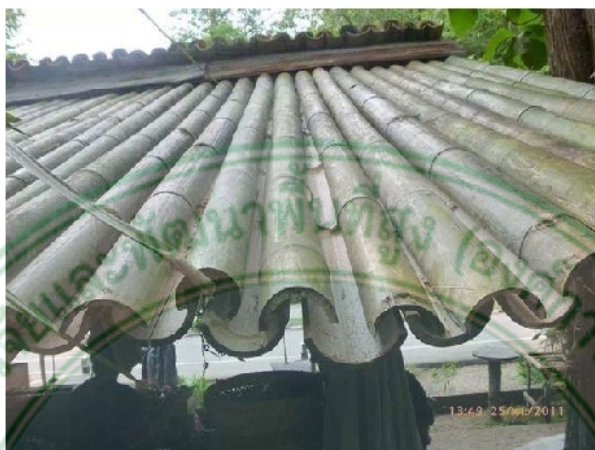
ภาพที่ 28 ตัวอย่างหลังคาที่ผลิตจากลำไผ่ สามารถใช้ไผ่ที่มีขนาดเส้นผ่าศูนย์กลางลำใหญ่ รวมถึงไผ่ที่มีผนังปล้องบางมาใช้งานได้
