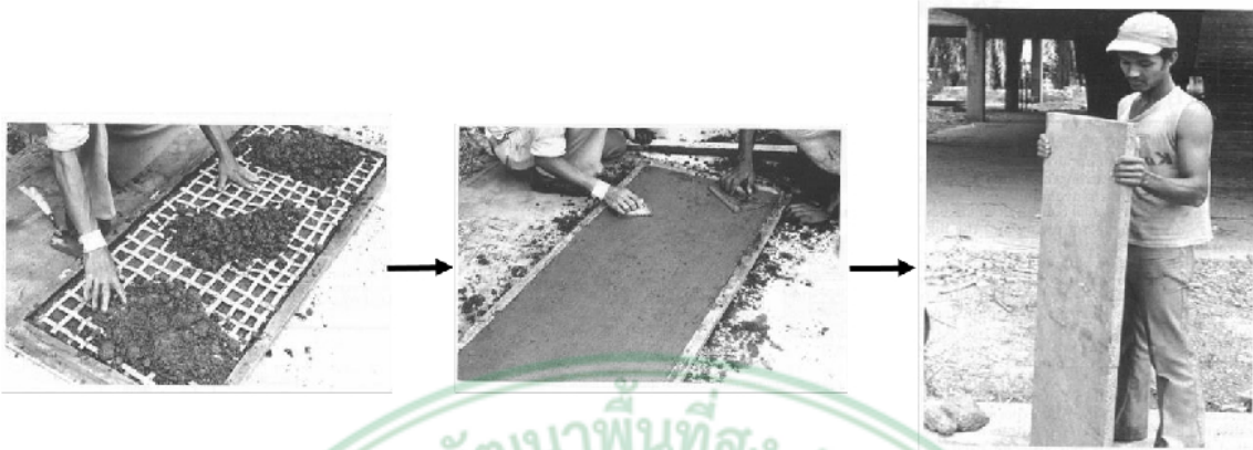
ภาพที่ 43 กระบวนการผลิตแผ่นพื้นสำเร็จ (Fabricated slab) จากไม้และซีเมนต์
