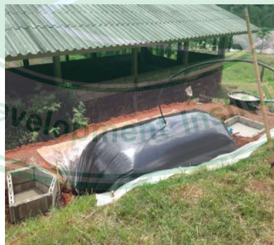
ภาพที่ 20 การติดตั้งระบบผลิตก๊าซชีวภาพแก่เกษตรกรที่เข้าร่วมทดสอบ
