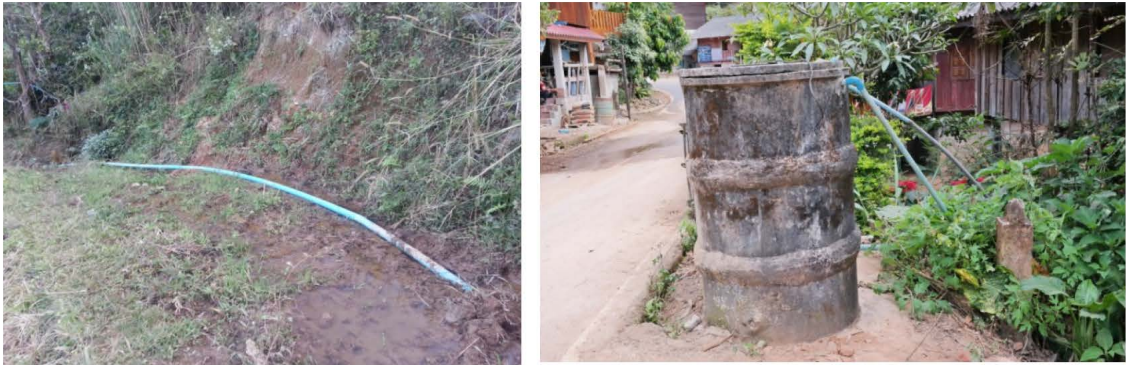
ภาพ 9 การส่งน้ำผ่านท่อและการใช้ท่อคอนกรีตเสริมเหล็กทำบ่อพักน้ำ ในการจัดการน้ำในช่วงฤดูแล้ง
