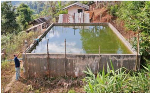
ภาพ 6 บ่อคอนกรีตเสริมเหล็ก ขนาด 1.70 \times 11.0 \times 8.0 เมตร
