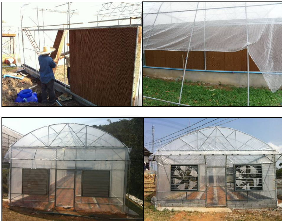
ภาพที่ 2 การติดตั้งแผงรังผึ้งและพัฒลมคูอากาศสำหรับโรงเรือนลดอุณหภูมิอัตโนมัติ
