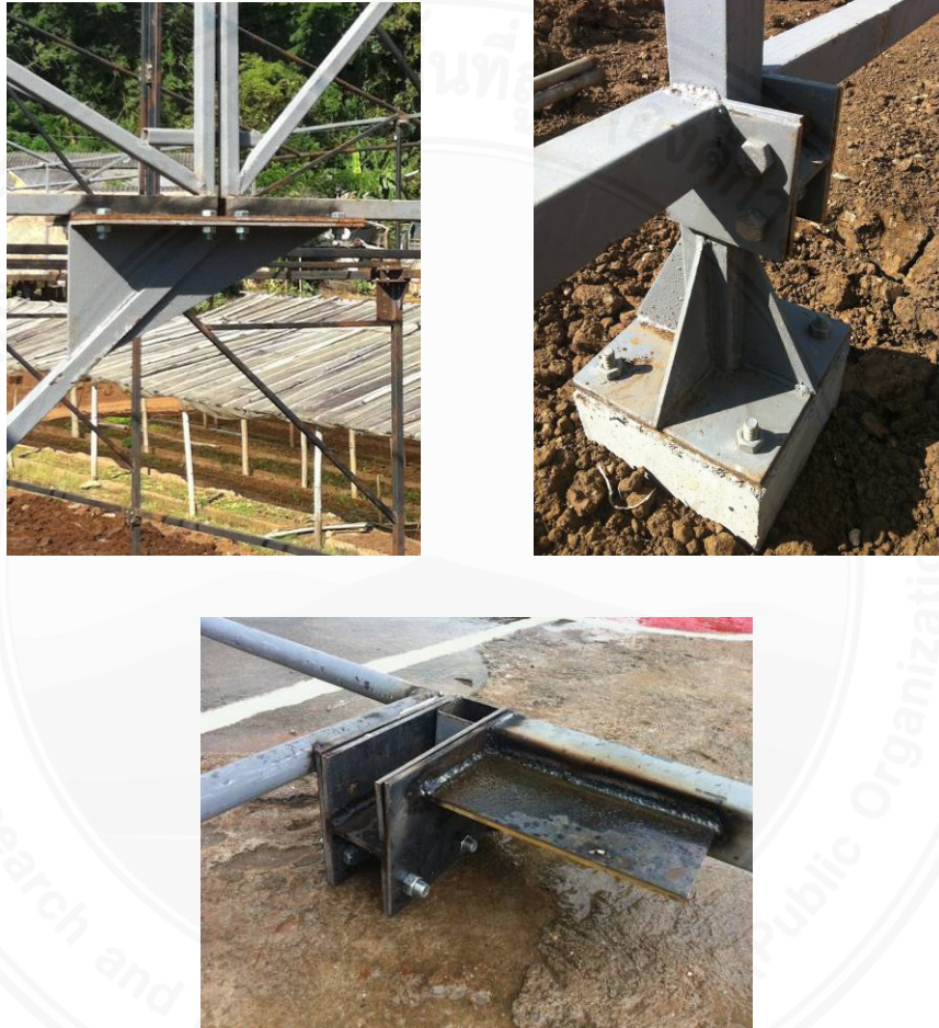
ภาพที่ 19 แผ่น plate ที่เป็นตัวเชื่อมในแต่ละชิ้นส่วนโครงสร้างโรงเรือน
