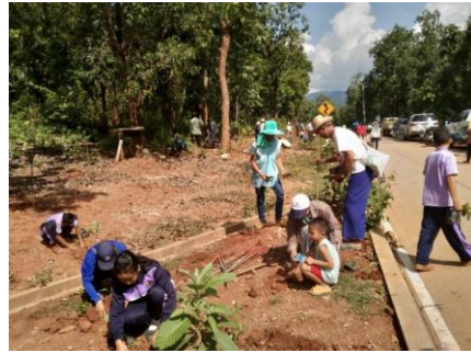
เตรียมแนวปลูกไม้ริมถนนภายในชุมชน
