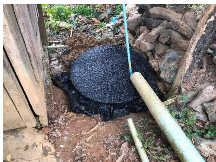
ติดตั้งระบบบำบัดน้ำทิ้งจากครัวเรือน
