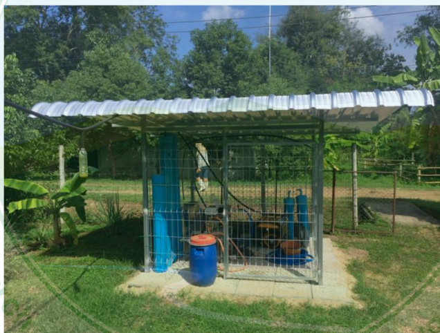
ภาพที่ 16 จุดสาธิตเครื่องผลิตกระแสไฟฟ้าและปั้มน้ำฟาร์มสัตว์ปีกโครงการหลวงแม่เหิยะ
