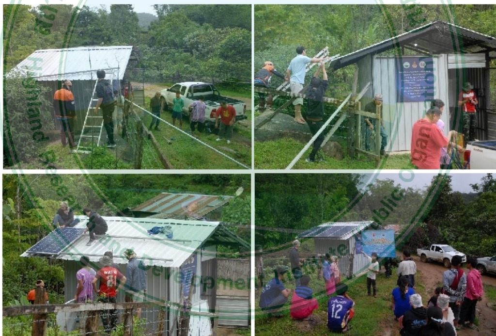
ภาพที่ 4.7 การฝึกปฏิบัติงานระบบสำรองไฟฟ้า บ้านขุนตั้นน้อย-บ้านปิพอ
