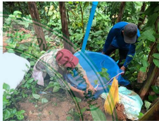
ติดตั้งบ่อบำบัดน้ำทิ้งครัวเรือน
