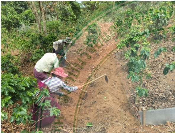
การขุดบ่อตกตะกอน ขนาด 80x100 เซนติเมตร
