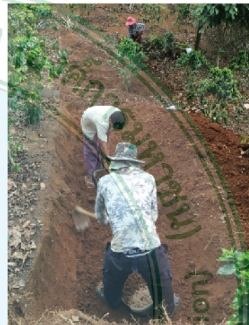
การขุดบ่อตกตะกอน ขนาด 80x100 เซนติเมตร
