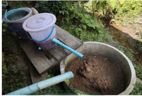
ภาพที่ 4.5 การติดตั้งถังดักไขมันที่เชื่อมต่อกับบ่อกรองวงซีเมนต์ที่ใส่หินและทรายเพื่อบำบัดน้ำทิ้งครัวเรือน
