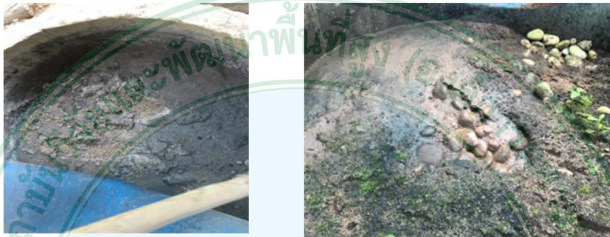
ภาพที่ 4.43 ลักษณะคราบไขมันบนชั้นกรองทราย และก้อนหินขนาดใหญ่ทำให้ชั้นกรอง ทรายไหลไปกับน้ำ
