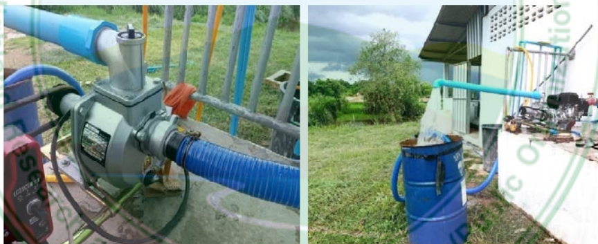
ภาพที่ 13 เครื่องปั้มน้ำแบบหอยโข่ง ขนาดท่อ 2 นิ้ว
