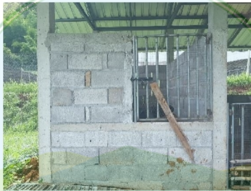
รูปแบบที่ 3 สร้างคอกเหนือพื้นดิน ไม่เทพื้น
