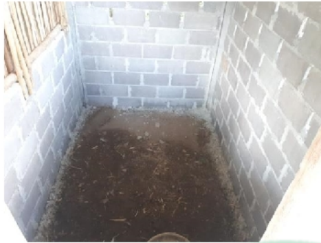
รูปแบบที่ 1 ชุตหลุมไม่เทพื้น
