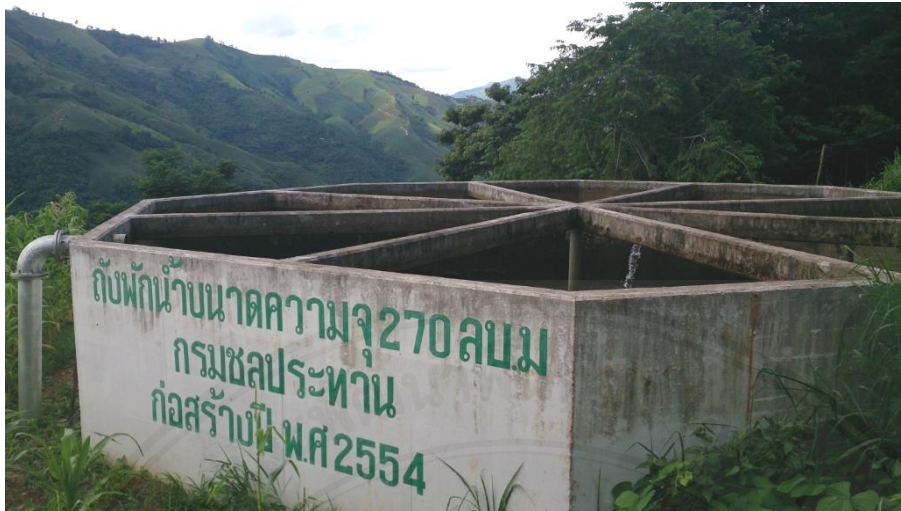
ภาพที่ 4-51 ถังเก็บน้ำของกรมชลประทาน
