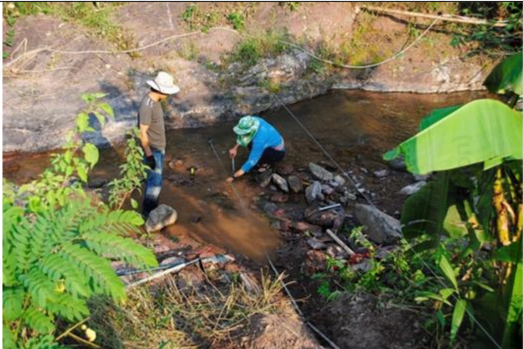
ชุดรื่องเพื่อทำการฝังท่อเหล็กร้อยสายสัญญาณ
