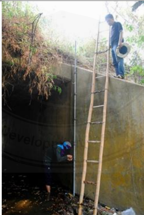
ติดตั้งท่อเหล็กกับสะพาน
