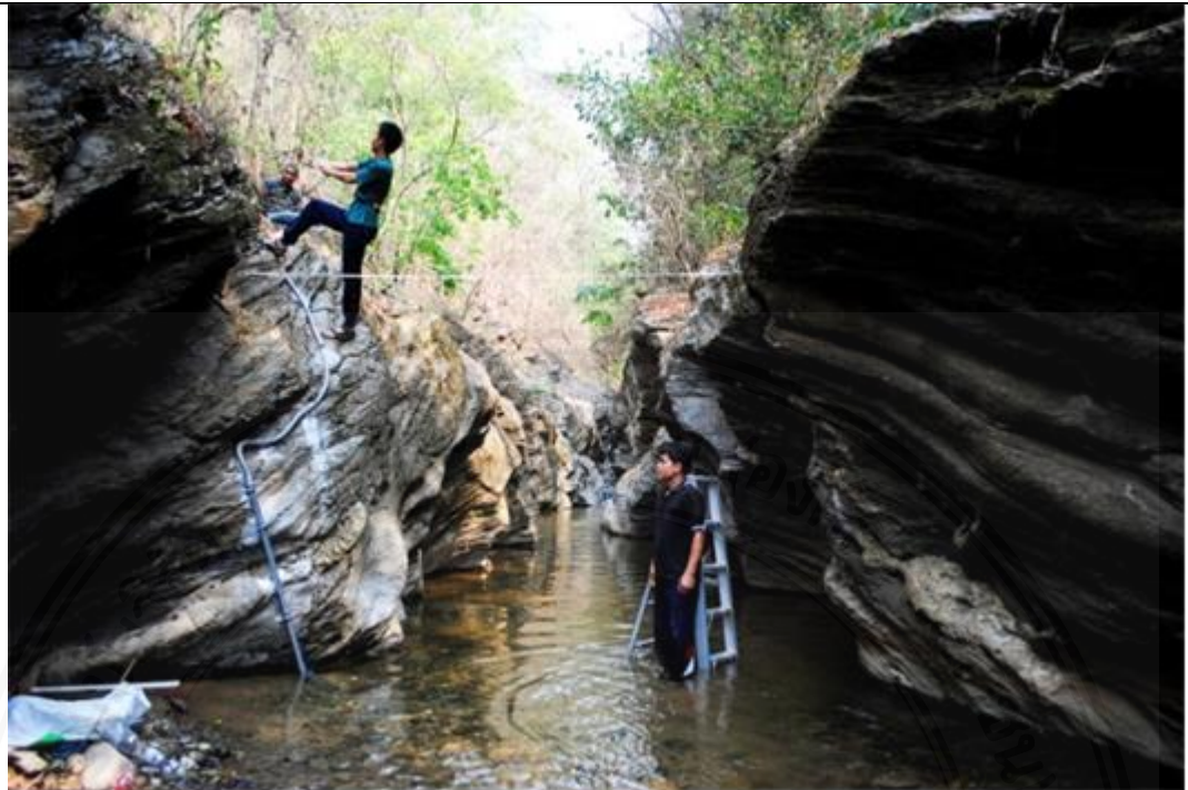
ติดตั้งท่อเหล็กตามร่องหิน
