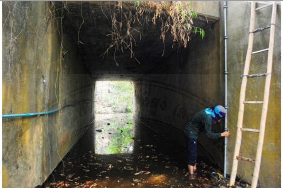
ท่อเหล็กร้อยสายสัญญาณ
