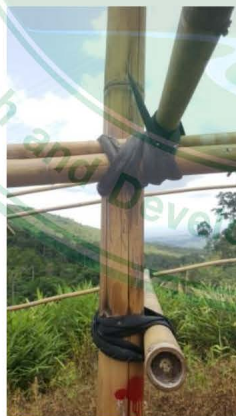
จ) ใช้ยางรัดจักรยานยนต์เก่ายึดโครงสร้างกับเสา
