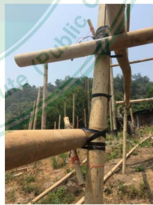
ฉ) ใช้สายรัดพลาสติกยึดโครงสร้างกับเสา
