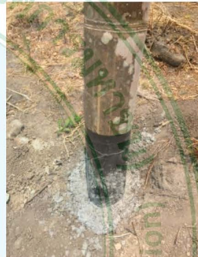
ง) การเทฐานเสาด้วยปูนร่วมกับใช้พลาสติกดำหุ้มโคนเสา
