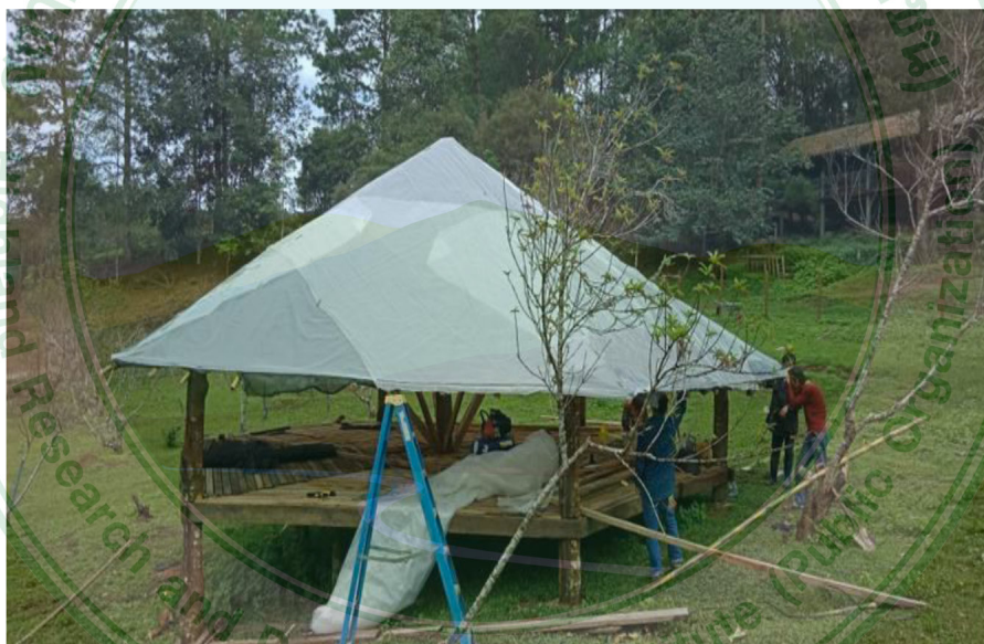
ภาพที่ 4.1 สภาพโรงเรือนแกะทดลองก่อนการปรับปรุง
