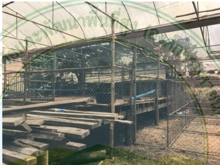
ภาพที่ 4.6 สภาพโรงเรือนแกะทดลองก่อนการปรับปรุง
