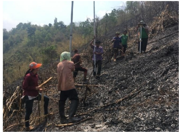
ภาพที่ 4.18 การวางผังคูรับน้ำขอบเขา
