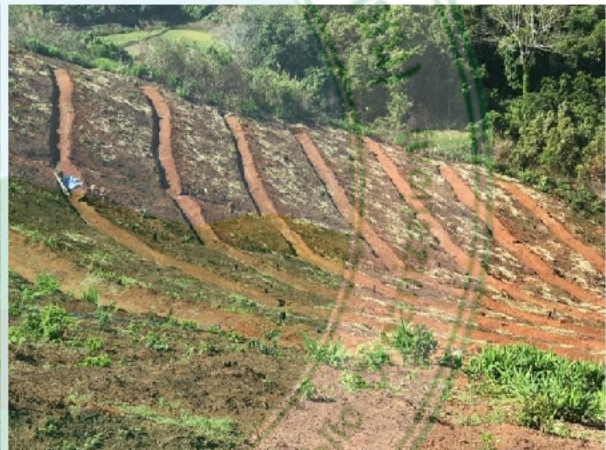
ภาพที่ 4.22 คูรับน้ำขอบเขาที่สำเร็จแล้ว
