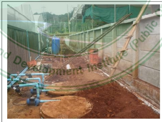
กำแพงกันดินที่กำลังก่อสร้างที่สถานี ฯ ปางตะ
