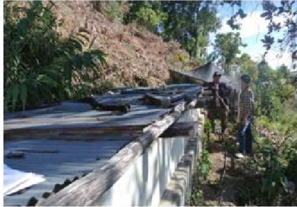
บ่อเก็บน้ำบ้านแม่จันทรง
