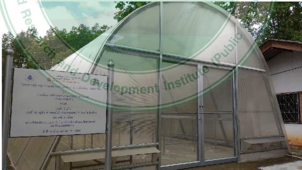
ภาพที่ 4.12 ระบบบ่อแห้งพลังงานแสงอาทิตย์ แบบเรือนกระจก ที่ได้รับการสนับสนุนแบบมีค่าใช้จ่าย
