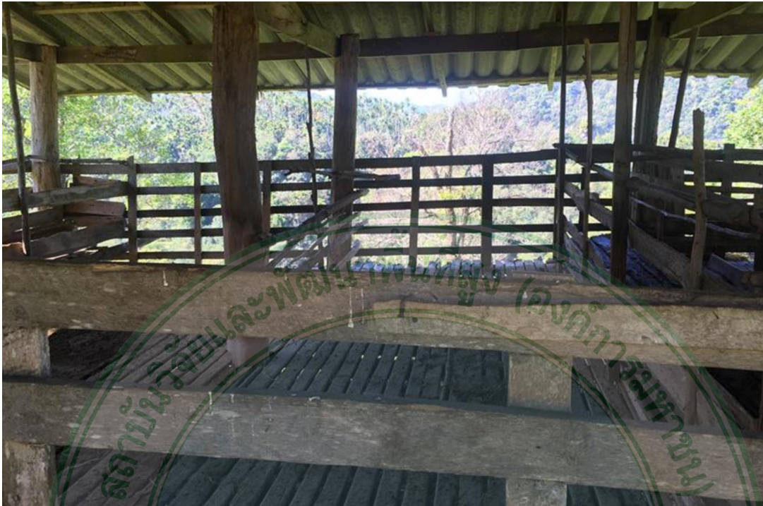
ภาพที่ 27 สภาพภายในคอกที่ใช้ในการเลี้ยงแกะชนของกลุ่มเกษตรกรบ้านห้วยห้อม
