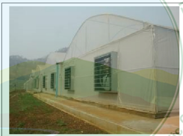
ภาพที่ 1 โรงเรือนควบคุมอุณหภูมิแบบแผ่ขนาด 18 x 40 ตารางเมตร ที่สถานีฯ ปางดะ
