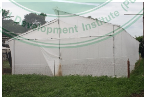
ภาพที่ 5 โรงเรือนแบบที่ 3 (รูปแบบใหม่หลังคาเหล็กคลุมด้วยพลาสติกใส ด้านข้างติดผ้าสับบอนด์) ที่ศูนย์ฯ ห้วยลึก อ.เชียงดาว จ.เชียงใหม่
