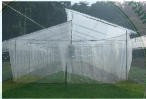
ภาพที่ 4 โรงเรือนแบบที่ 2 (รูปแบบใหม่หลังคาเหล็กคลุมด้วยพลาสติกใส ด้านข้างติดมุ้งตาข่าย) ที่ศูนย์ฯ ห้วยลึก อ.เชียงดาว จ.เชียงใหม่
