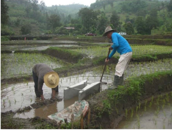
การติดตั้ง cut throat flume
