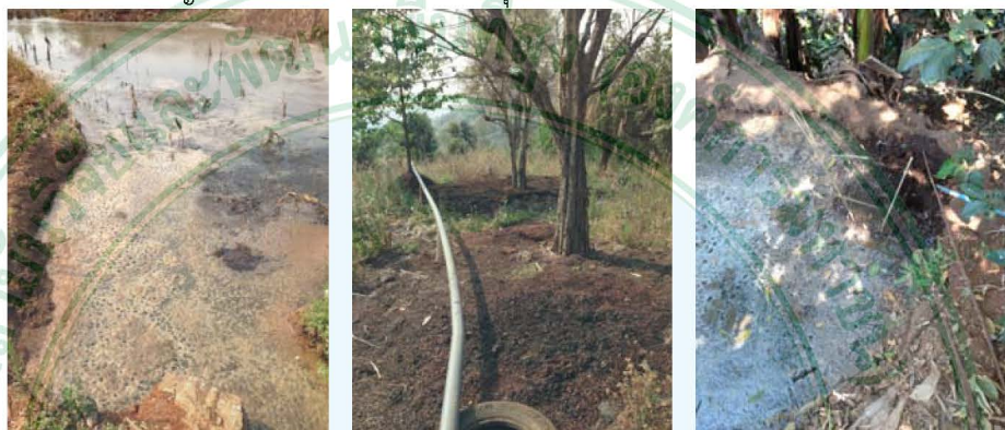
ภาพที่ 2 ตัวอย่างบ่อดินเก็บน้ำเสียและพื้นที่เก็บเปลือกกาแฟที่เหลือทิ้งจากการแปรรูปกาแฟของกลุ่มที่ต้องมีการปรับปรุงโดยการจัดทำบ่อดินเก็บน้ำทิ้งและน้ำเสีย และจัดทำพื้นที่เก็บเปลือกกาแฟให้เหมาะสม
