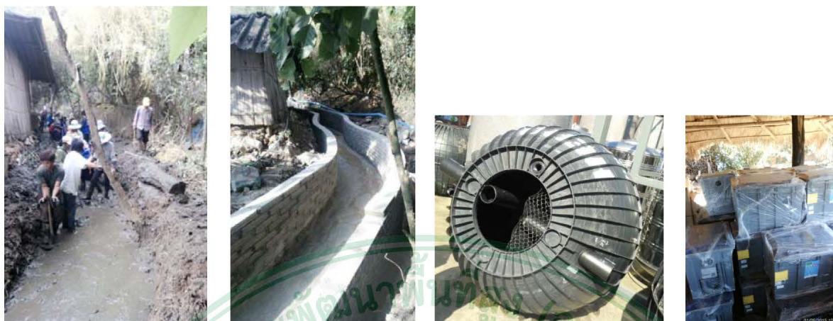
กรรมวิธีที่ 2 การปรับปรุงเส้นทางระบายน้ำและติดตั้งถังบำบัดน้ำเสีย ซอย 3/5
